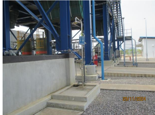
รูปที่ 3-42 จุดล้างตาและอาบน้ำ บริเวณพื้นที่กักเก็บสารเคมี
