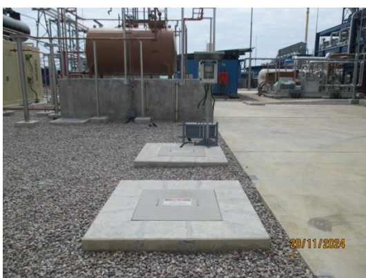
รูปที่ 3-26 บ่อแยกน้ำ/น้ำมัน (Oil Separator)
