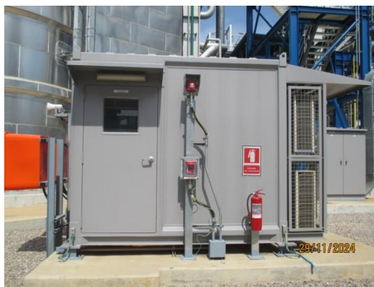
รูปที่ 3-5 เครื่องมือตรวจสอบคุณภาพอากาศ แบบต่อเนื่อง (CEMS)
