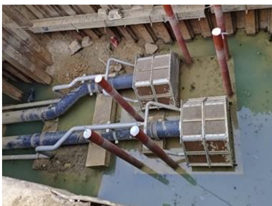
รูปที่ 3-20 ตะแกรงดักขยะที่ปลายท่อสูบน้ำบริเวณ แม่น้ำแม่กลอง
