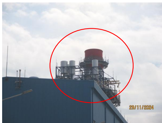
รูปที่ 3-11 Silencer บริเวณ HRSG
